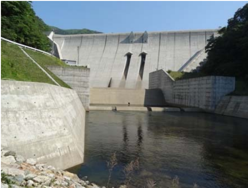
志津見ダム平常時の状況 (H25.5.24 15:40撮影 放流量3.7 m 3 /s)
