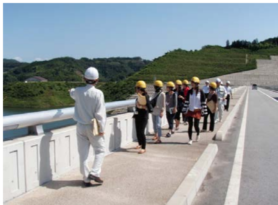
ダム天端道路
