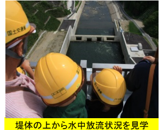
堤体の上から水中放流状況を見学
