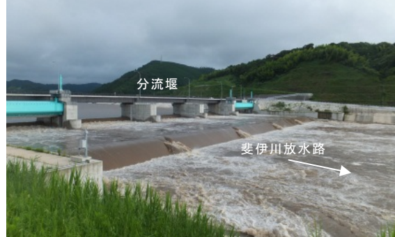
斐伊川放水路（開削部）
