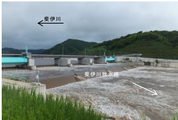
斐伊川放水路（分流堰）
