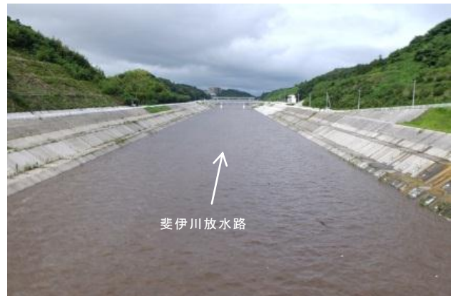
斐伊川放水路（開削部）
