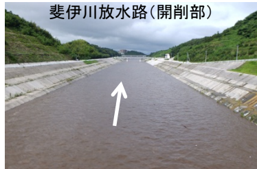
斐伊川放水路(開削部)
