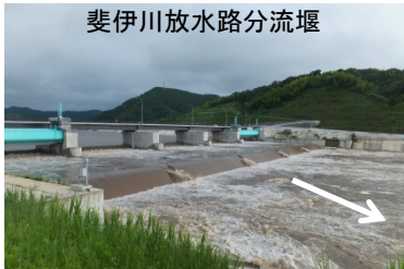
斐伊川放水路分流堰
