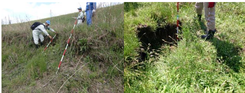
写真 点検実施状況
