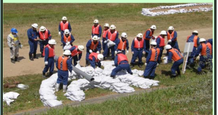
釜段工法の演習状況
