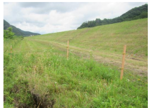
写真3 立ち入り防止柵の設置状況
