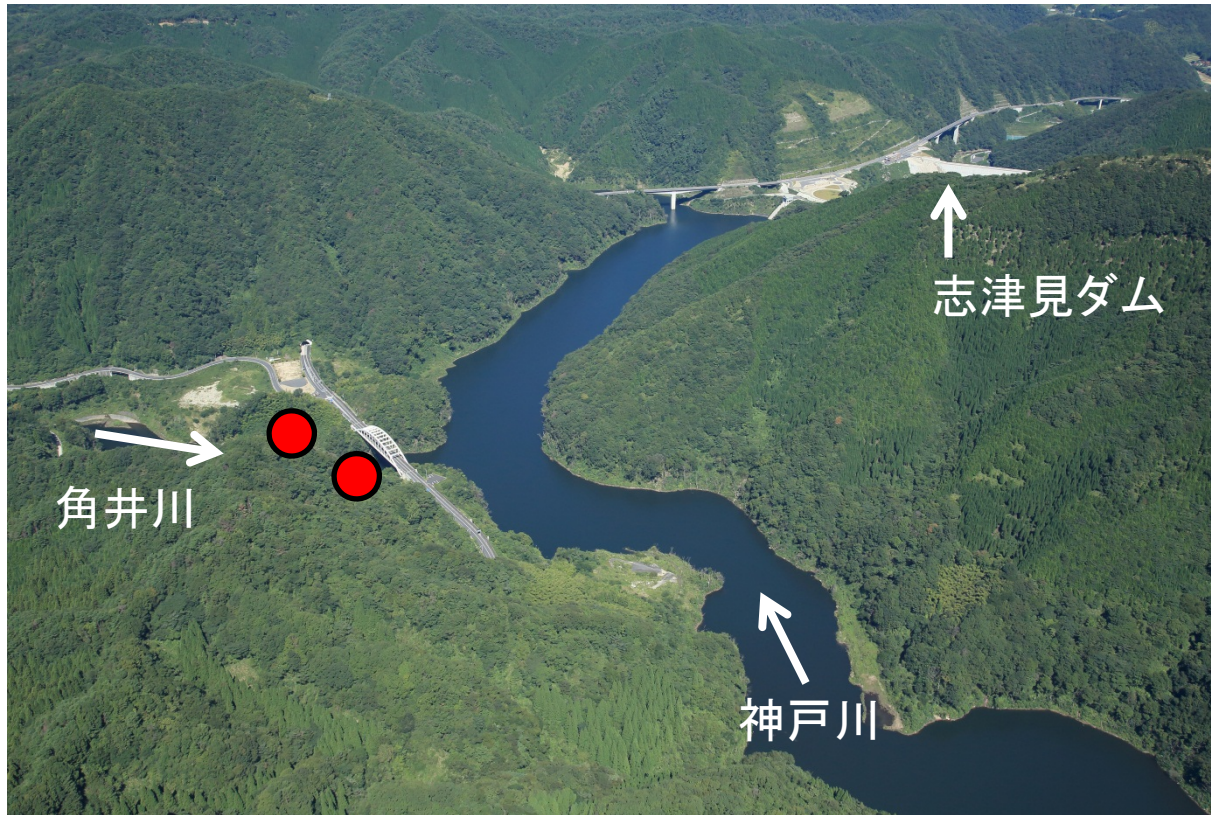
ダム上流からの写真
