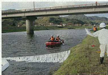
＜ボートによるオイルフェンス展張＞
