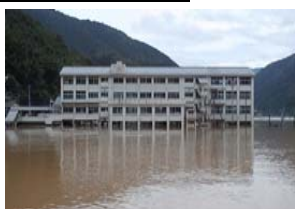
H26.8避難所2階の浸水 (徳島県)
