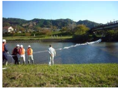
<雲南市によるオイルフェンス展張>
