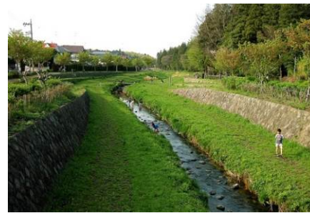
写真1 天端コンクリートを打たずに土で埋め戻し、植栽で和らげている事例
