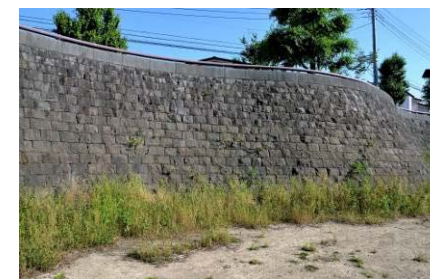
写真14 練石積：深目地仕上げ
