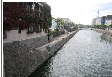
写真1 カラコロ広場前京橋川護岸
