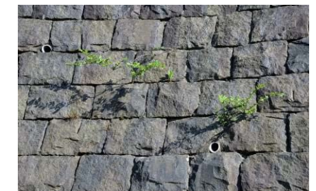
写真15 練石積：深目地仕上げ（同左）
