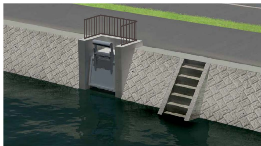
図6 樋門施設等の管理用階段工
