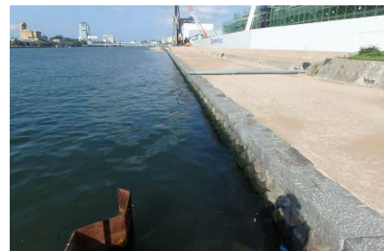
写真3 天端石による天端処理(松江地方合同庁舎前)
