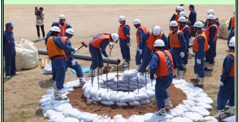
かま だん 釜段工法の演習状況
