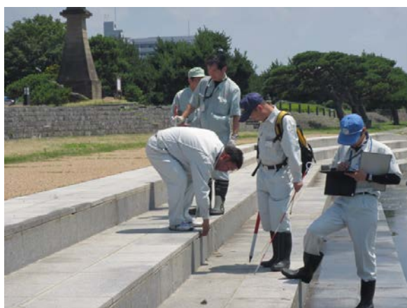
公園管理者(市の職員)との点検状況
