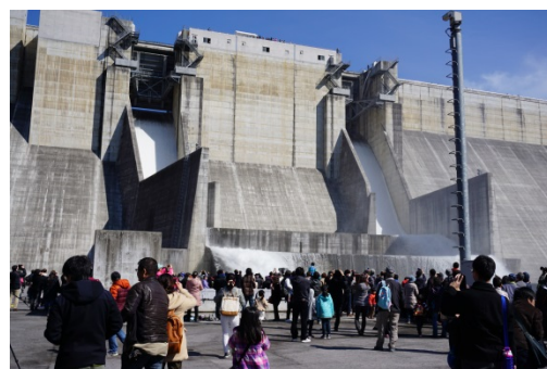
前回の点検放流
