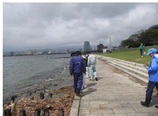
河川協力団体との点検実施状況
