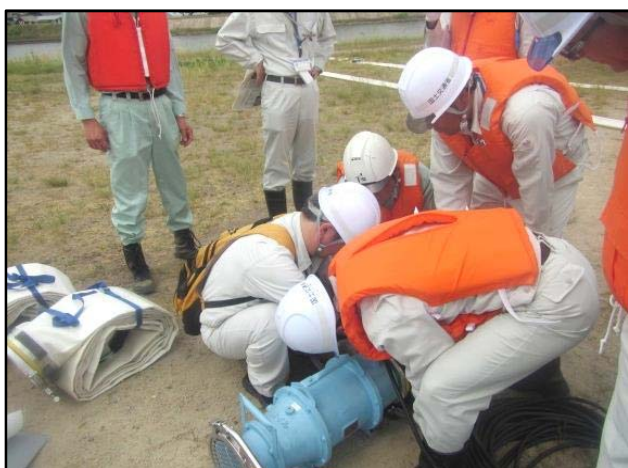
・排水ポンプ、ホース接続作業
