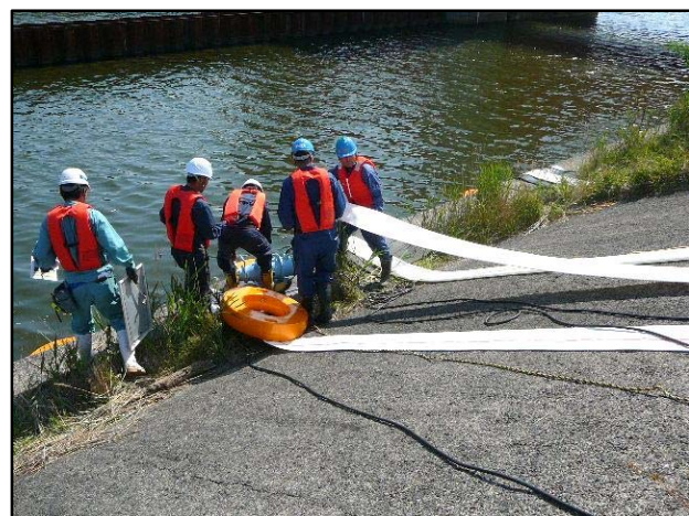
・排水ポンプ設置作業
