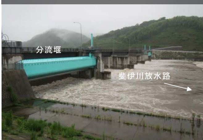
斐伊川放水路分流堰付近（7/7 6:10時点）
