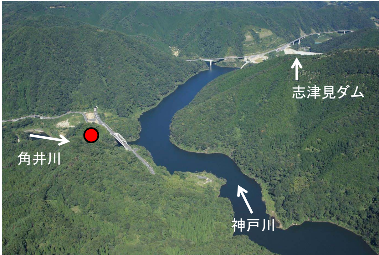
ダム上流からの写真
