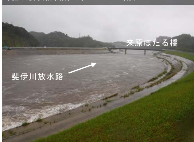
斐伊川放水路開削部（9/30 15:40 時点）
