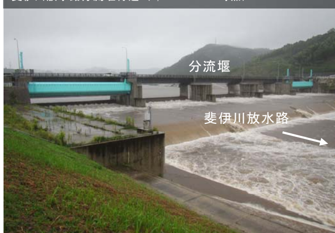
斐伊川放水路分流堰付近（9/30 15:30 時点）
