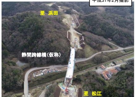
写真① 静間・仁摩道路 静間跨線橋付近の工事の様子
