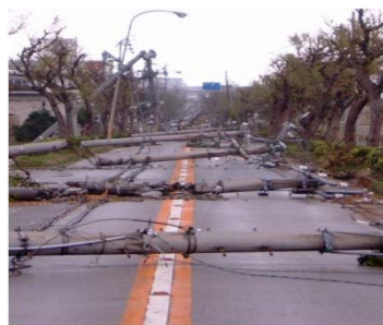
＜電柱の倒壊による道路閉塞の事例＞
