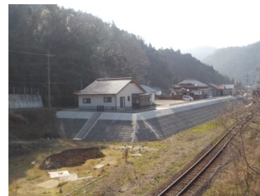
宅地嵩上げ整備箇所(松川橋付近)
