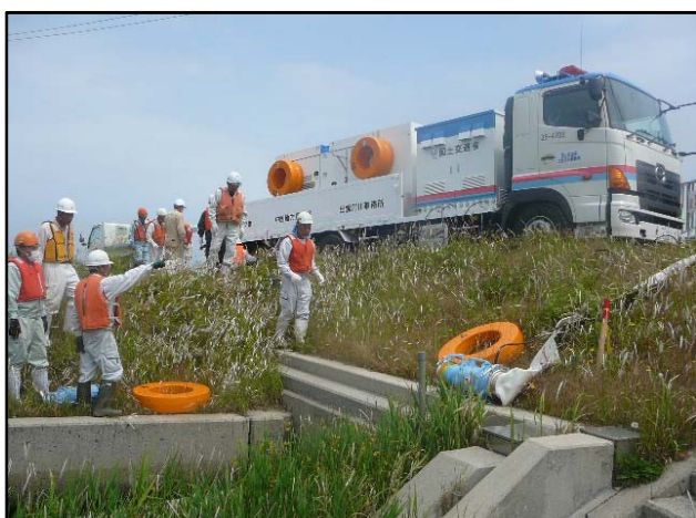
排水ポンプ車(30m 3 /min)高揚程 ・車両設置作業
