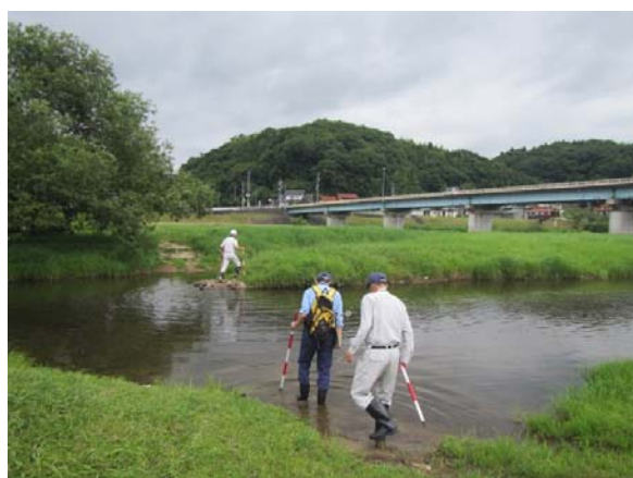
施設管理者(市の職員)との点検状況
