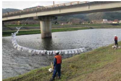
＜安来市班によるオイルフェンス展張＞
