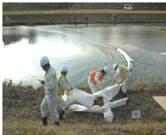
＜国土交通省班によるオイルフェンス展張＞
