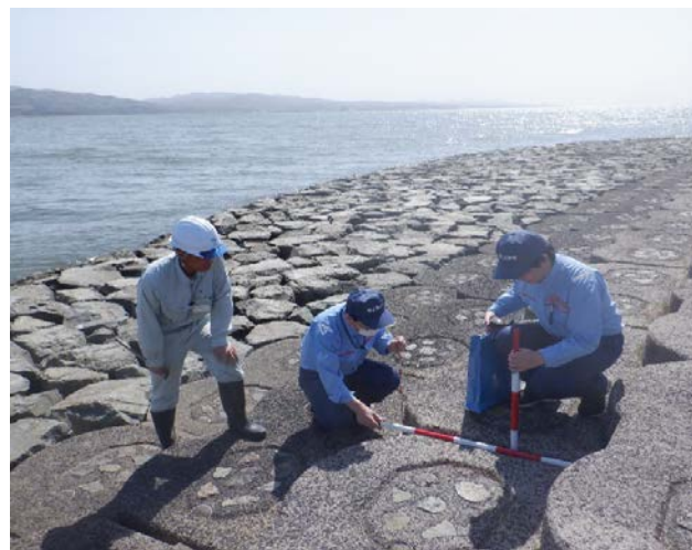
末次環境護岸【宍道湖】での点検状況
