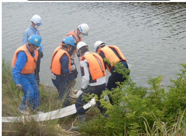
・ 排水ポンプ、ホース敷設作業
