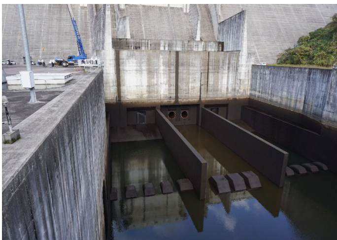
点検のため減勢工の水位を低下させた状態
