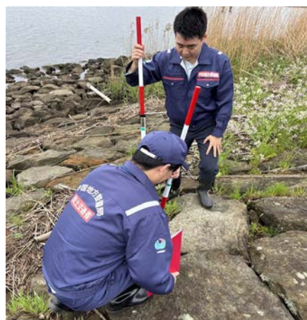
宍道湖西岸環境護岸【宍道湖】での点検状況
