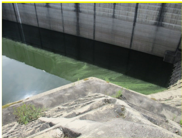
尾原ダム 堰堤右岸側
