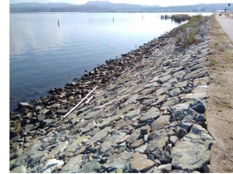
アオコ確認箇所:⑨出雲市斐川町坂田地先 アオコレベル :レベル1~2 確認日 :令和3年11月17日
