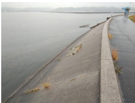
アオコ確認箇所:②出雲市斐川町荏原地先 アオコレベル :レベル2 確認日 :令和3年11月22日
