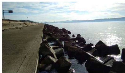
アオコ確認箇所: 松江市長江町地先 アオコレベル : レベル1 確認日 : 令和3年11月30日
