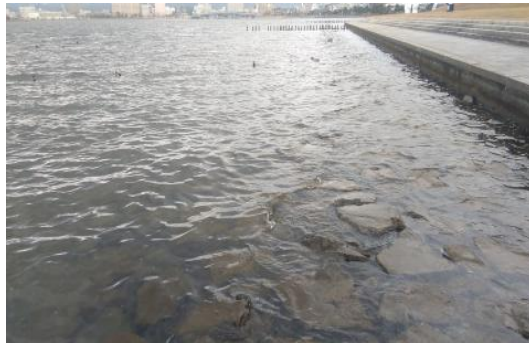
アオコ確認箇所: 松江市袖師町地先 アオコレベル : レベル1 確認日 : 令和3年12月8日
