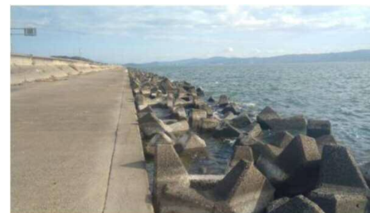
アオコ確認箇所: 松江市東長江町地先 アオコレベル : レベル1 確認日 : 令和3年12月13日
