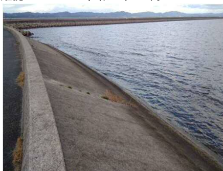
アオコ確認箇所: 出雲市斐川町荏原地先 アオコレベル : レベル2~3 確認日 : 令和3年12月13日
