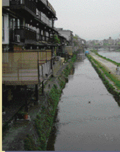
京都：鴨川沿いに並ぶ商業施設
