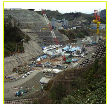
下流よりダムサイトを臨む
