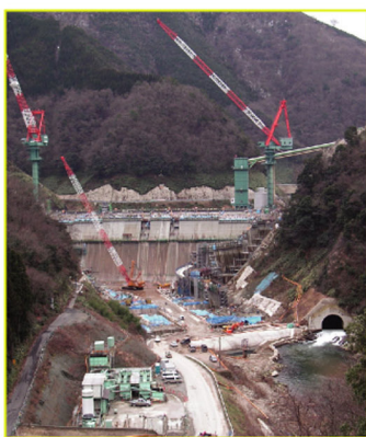
下流よりダムサイトを臨む
