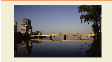
現在の松江大橋の全景写真
