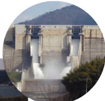
非常用洪水吐きからの試験放流状況
