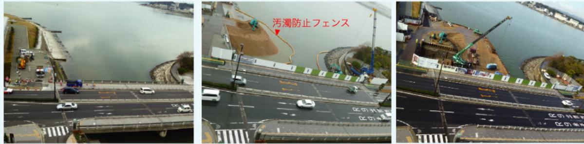
作業ヤードとなる盛土については、水中の土砂を投入する際の濁りを抑えるために、汚濁防止フェンスを設置し、作業を行いました。その後、締切用の仮設矢板を打設しました。
