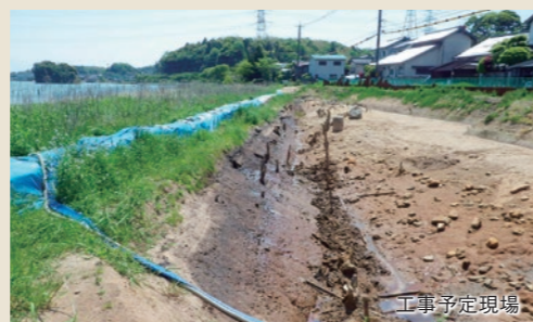
工事予定現場
