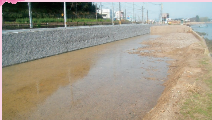
矢田地区築堤護岸外工事 護岸約120mが完了しました。
