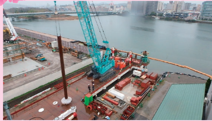
向島川樋門新設工事 仮設構台の施工及び護岸の地盤改良を行います。
