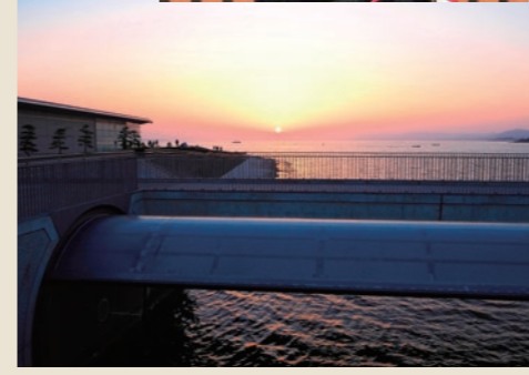
眺望への影響を抑えた天神川水門(ライジングセクタゲート)
