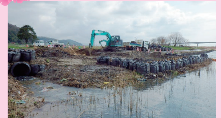
福富地区樋門外工事 樋門の新設工事を行っています。
