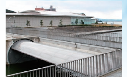
水門の形式 水門の高さを抑え、眺望を阻害しないライジングセクタゲートを採用しました。
