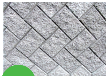
素材1-1 従来型の景観配慮タイプのコンクリートブロック
