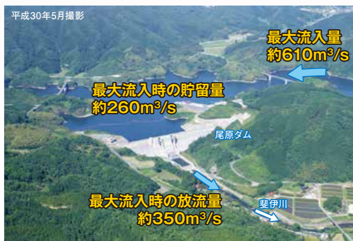
台風24号洪水にともなう尾原ダムの運用
