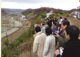
斐伊川放水路 (開削部)
