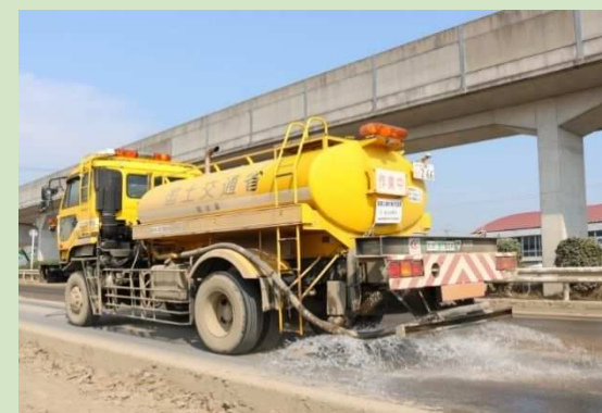
国道486号における散水作業 (岡山県倉敷市)
