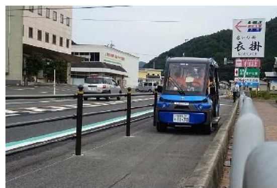
▲国道に防護柵を設置
