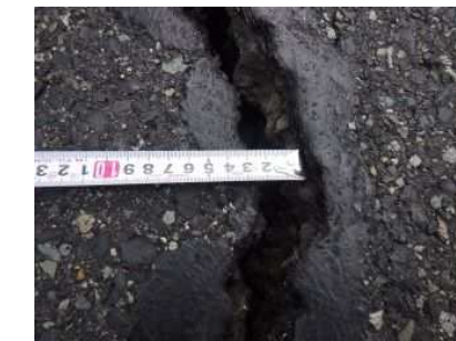
舗装路面のクラック（青谷町）
