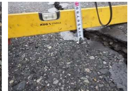
舗装路面のクラック（青谷町）
