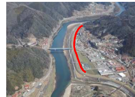
堤防整備・強化、河道掘削
