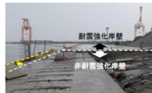
岸壁等耐震化
