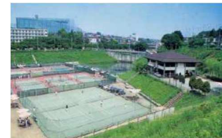
雨水貯留・排水施設の整備
