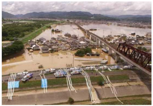
排水ポンプ車派遣による緊急排水支援
