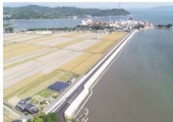
高潮堤防整備
