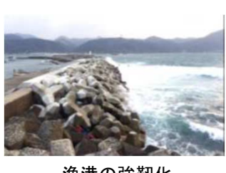
漁港の強靱化 (防波堤嵩上げによる越波防止)
