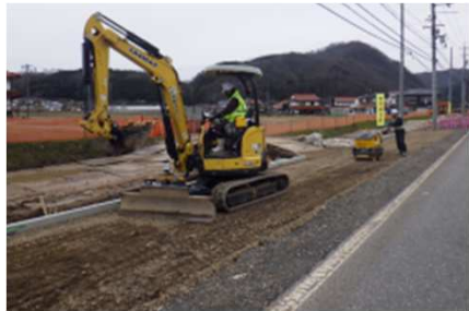
小型ICT建機による施工
