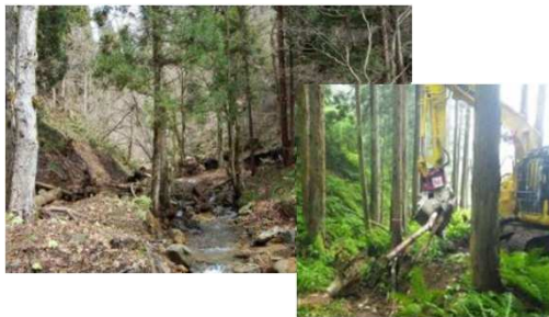
治山対策(危険木除去 等)
