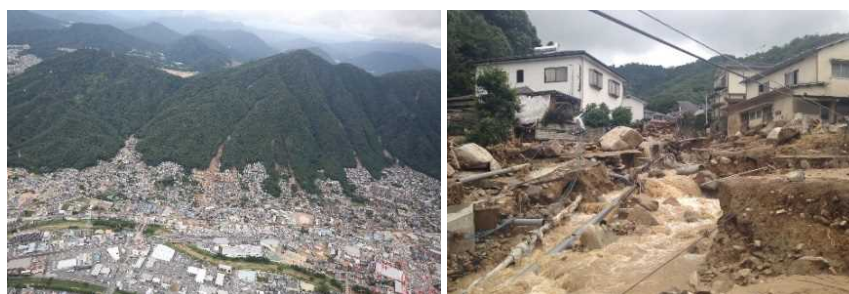
▲平成 26 年 8 月豪雨による広島土砂災害の被害の様子
