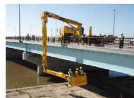
橋梁点検車による点検 出典: 中国地方整備局
