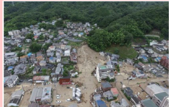
平成30年7月豪雨による土砂災害
