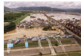
排水ポンプ車派遣による緊急排水支援
