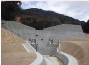
円滑な避難を確保する砂防堰堤の整備
